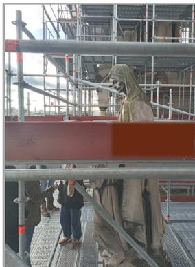
L'installation des échafaudages sur les tours de la façade est une opération qui demande énormément de précision, dans des conditions difficiles. Elle se termine en ce moment. Les échafaudages serrent au plus près les maçonneries et sculptures qui auront besoin d'être restaurées. C'est le cas en particulier de la statue de sainte Anne présentant la Vierge Marie; la pierre est rongée par les intempéries et la pollution. Elle fait partie du programme de restauration.
